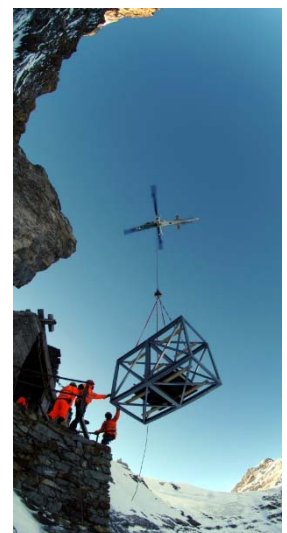
K-MAX bei der Montage mit TLP_30_55
