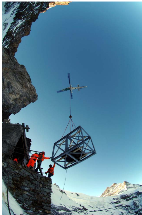
Fig. 4: KAMAN K-1200 "K-MAX" avec TLP_55_30 (WLL 30 kN). Crédit photo : SBV
