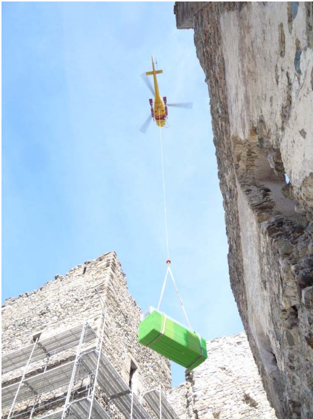
Abb.3: AS 350B3e Heli Bernina AG mit TLDS+_14_30 (WLL 14 kN). MFG Heli Bernina AG
